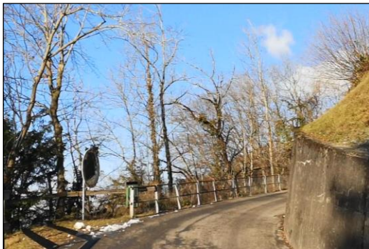
Abb. 10, 11 Anhaltesichtweiten in Kurven
