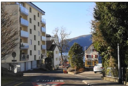
Abb. 14, 15 Trottoir endet im Knotenbereich
