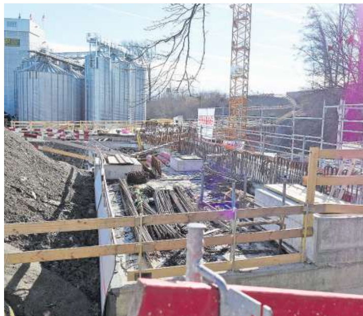
Nordportal der Südwestumfahrung Sins: Die Gemeinde hat schon 8 Millionen Franken dafür bereit. Bild: Eddy Schambron
